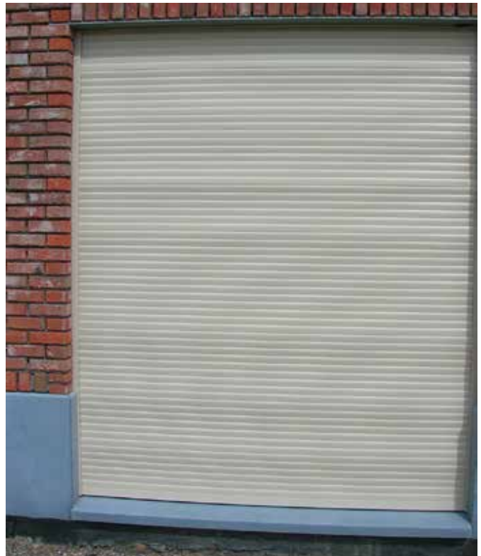
Bild 4: Welligkeit von Rollladenpanzern
